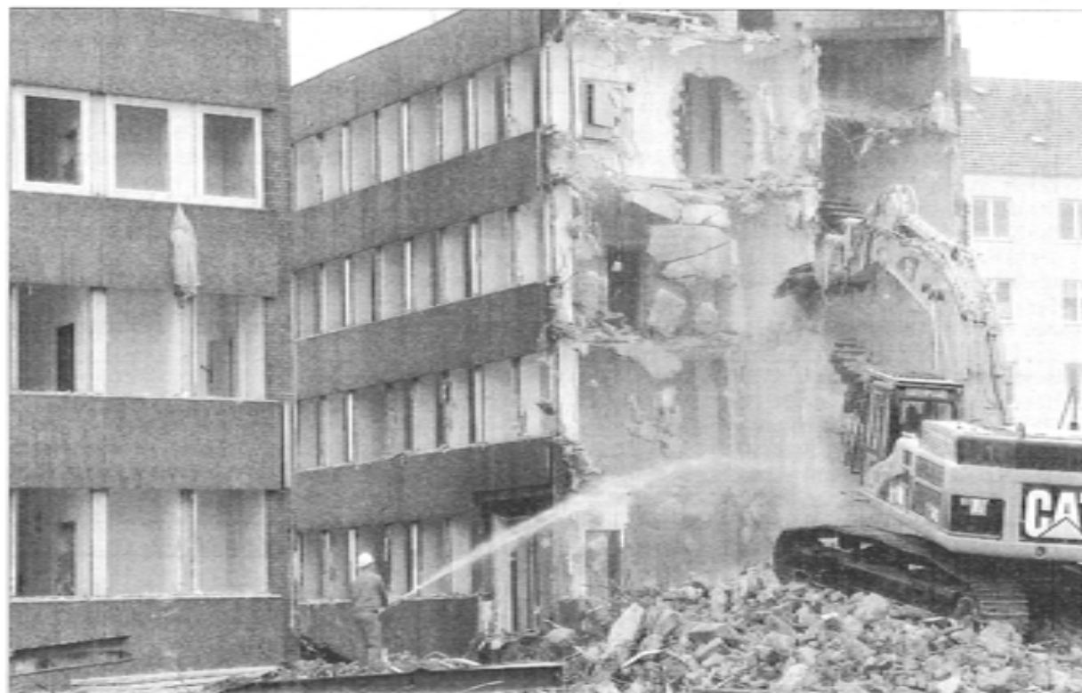
Der Anfang vom Ende: Ein erster Bagger gräbt sich in die Mauern des Landesbehördenhauses an der Franzstraße, das dem Neubau der AachenMünchener weichen wird. Foto: Andreas Herrmann
