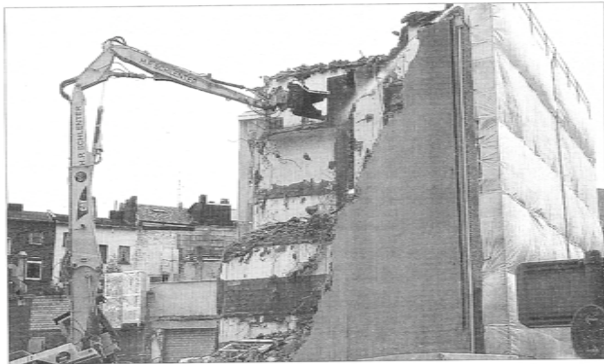
Glück für den Baggerfahrer mitten in der Mayerschen Buchhandlung: Morgens blendete noch die Sonne, mittags zogen dann endlich Wolken auf. Ein zweiter Bagger riss von hinten den Kinosaal des Bavaria ein. Foto: Harald Krömer
