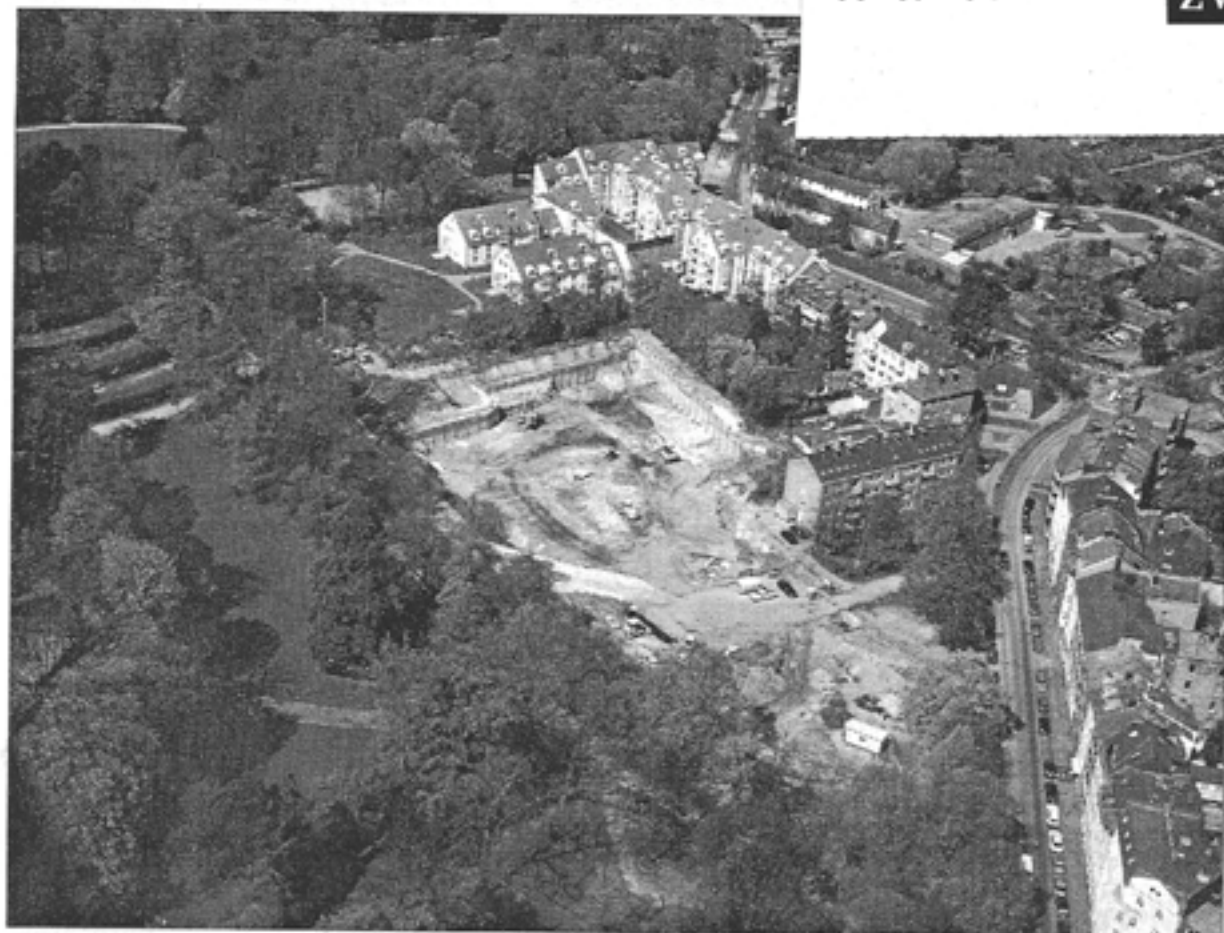
Großbaustelle im Überblick: An der Paßstraße ist für die neue Therme Aachens größtes Loch ausgebaggert.
