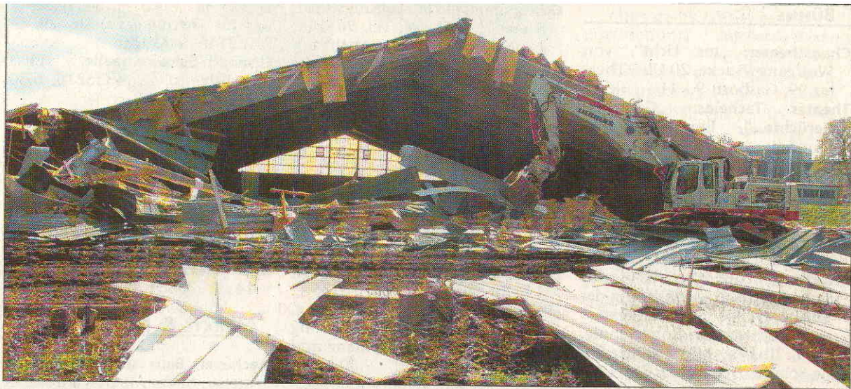
In die Zange genommen: Die PTSV-Tennishalle wird seit gestern nach den – letztlich im Kompromiss gelösten – Querelen um Pachtverträge dem Erdboden gleichgemacht. Foto: Michael Jaspers
